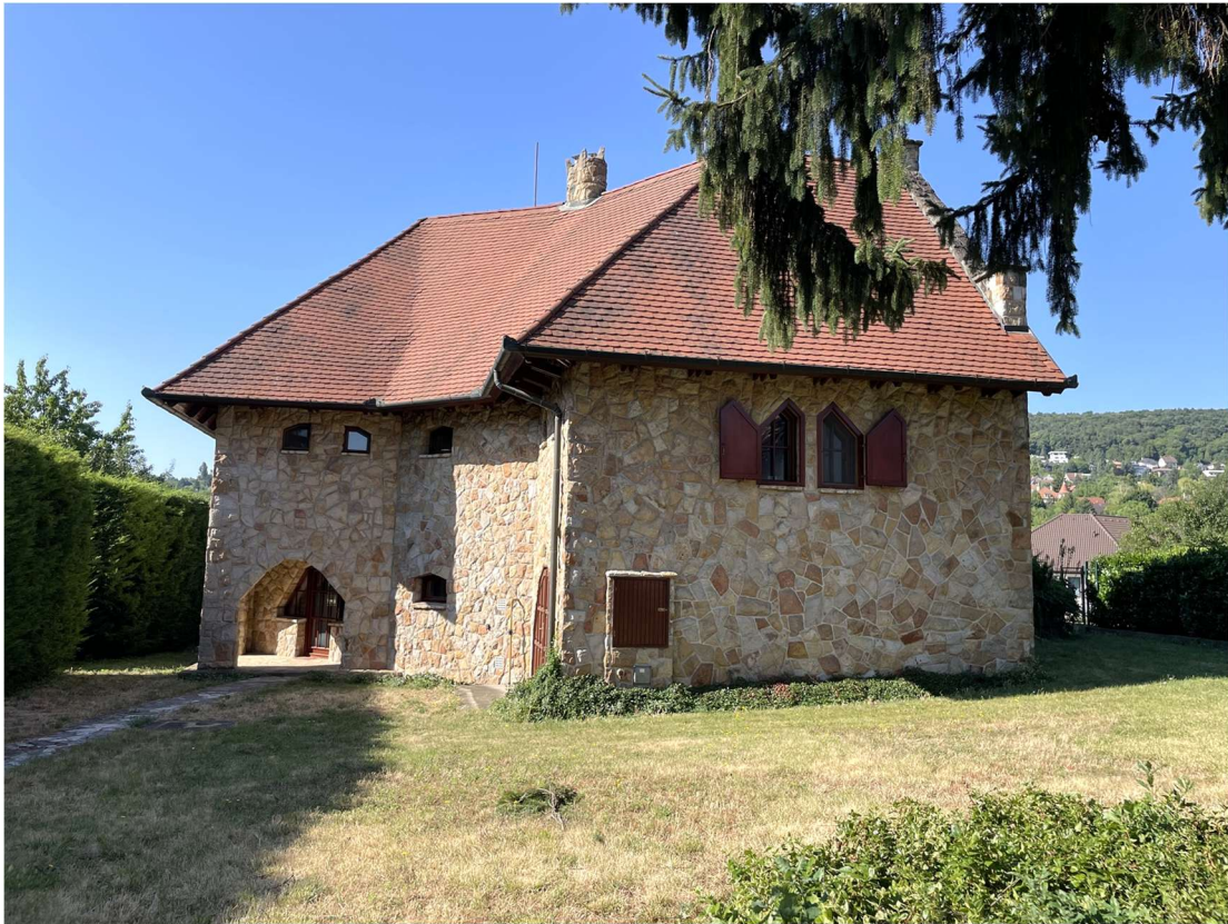
Das dreistöckige Gebäude im Makovecz-Stil
